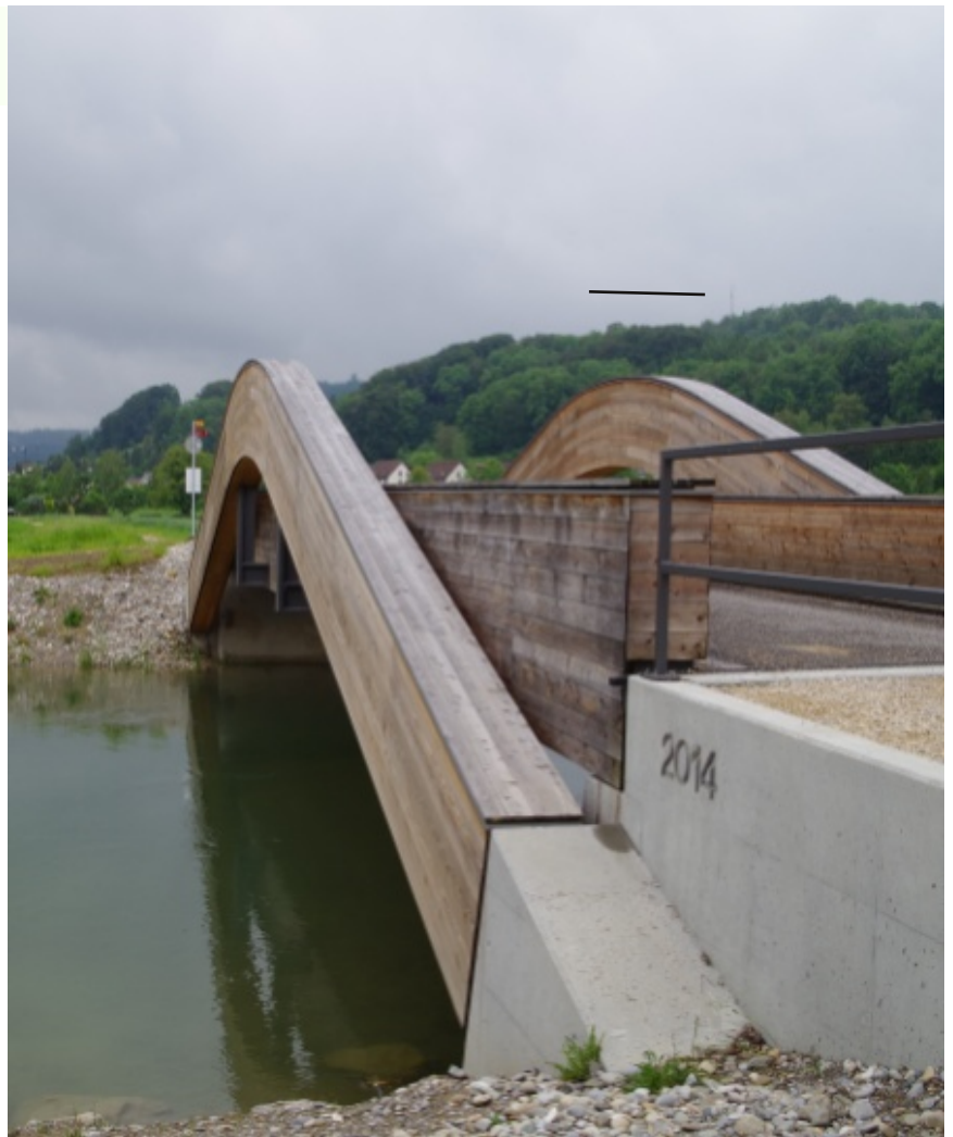
Neue Brücke ChlyRhy Rekingen (Foto: Hanspeter)
